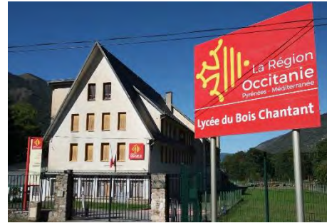
Photo 116 : Le Lycée du Bois Chantant à Bagnères-de-Luchon - Source : Citadia Conseil
