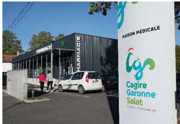
Photo 122 : La maison médicale intercommunale de Salies du Salat
