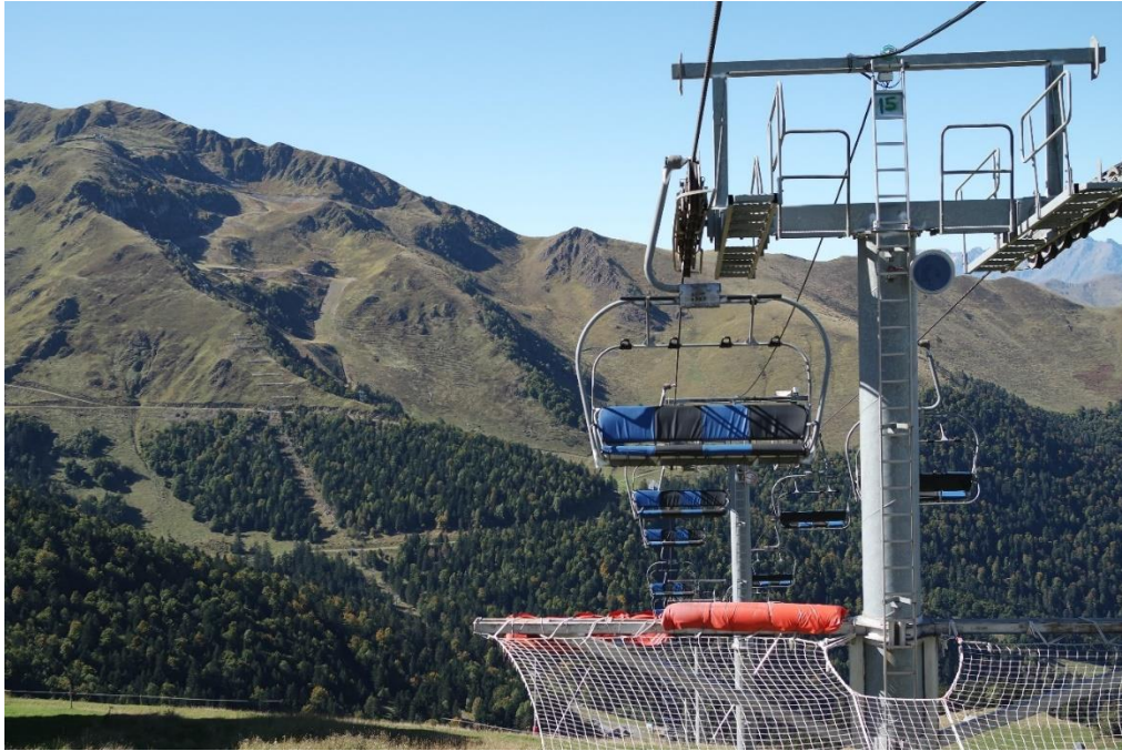
Photo 128 : Remontée mécanique à Luchon Superbagnères - Source : Citadia
